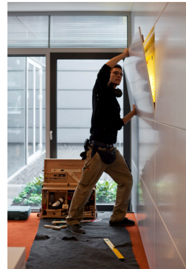
Wand mit Lichteffect: Ausrichten der Nutleistenaufhängung für das DuPont™ Corian® Paneel. Moderne LED-Technik bringt den rückseitig gefrästen Schriftzug auf dem transluzenten Corian® zum Leuchten.
